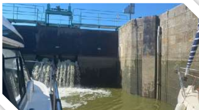
Dans le sas de l'écluse du Châtelier
